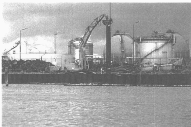
Canale Industriale Sud. Infissione del palancoiato di acciaio a ridosso della riva nord preesistente.
