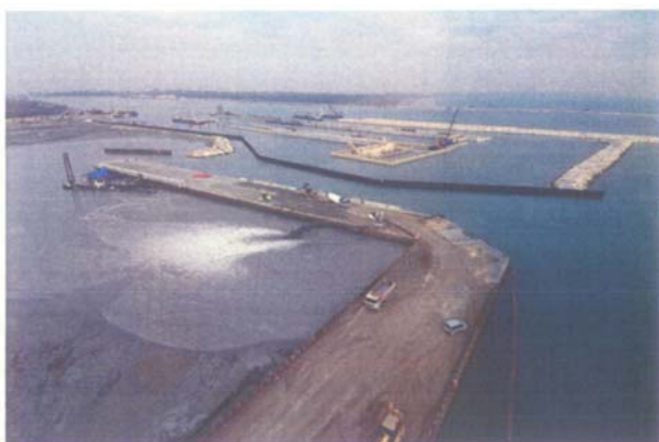
Reflimento del materiale dragato nell'avanconca, a formazione del rilevato delle infrastrutture di prefabbricazione dei cassoni di alloggiamento delle paratoie
