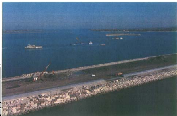
In primo piano il rinforzo del molo sud di S. Nicolò, al centro mezzi in opera per il dragaggio e il versamento del materiale di protezione dei fondali a S. Nicolò
