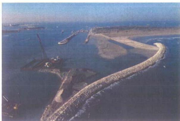
Porto rifugio - lato mare/tura 1^ fase: la scogliera di protezione del bacino lato mare completata, sulla sinistra il palancoato di chiusura del bacino in fase di realizzazione, in secondo piano la scogliera sud del porto rifugio lato mare, quasi completata, sullo sfondo le conche per pescherecci e il bacino lato laguna del porto rifugio
