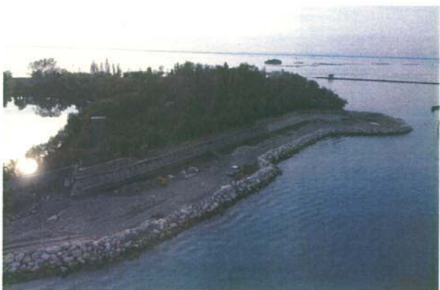
Conca di navigazione - opere di protezione della sponda del territorio lato Forte S. Pietro: la scogliera provvisoria dell'area di intervento in corrispondenza del forte S. Pietro
