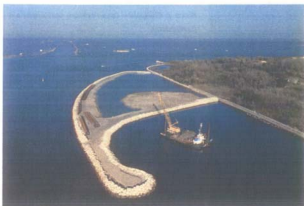
Porto rifugio - bacino lato laguna: terrapieno che delimita a nord il bacino lato laguna del porto rifugio. E' stata realizzata la scogliera, è in corso di realizzazione il riempimento
