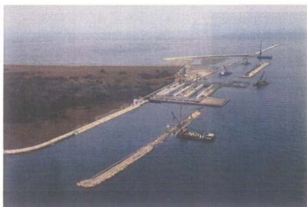
Porto rifugio - bacino lato laguna: formazione della scogliera lato canale a ridosso del palancoato precedentemente infisso, costituente la parete interna del bacino lato laguna del porto rifugio
