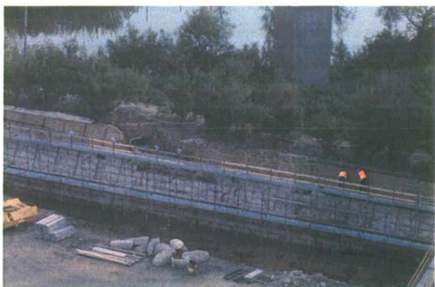
Conca di navigazione - opere di protezione della sponda del territorio lato Forte S. Pietro: l'intervento di restauro del muro del forte S. Pietro
