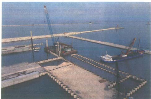
Conca di navigazione - opere civili per l'alloggiamento delle porte e delle strutture guida: parete combinata della testata lato mare, in fase di infissione
