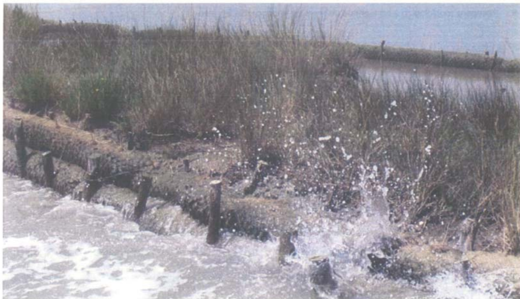
Protezione barene mediante buzzoni
