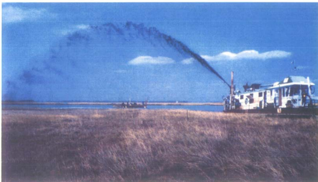
Protezione barene mediante rimpascimento
