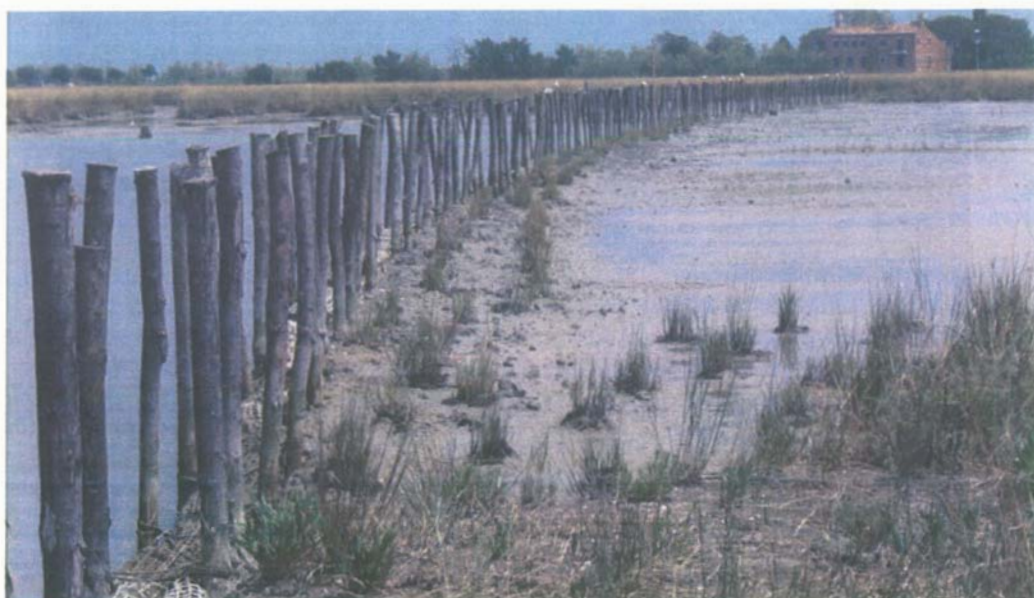
Protezione barene mediante fascinate
