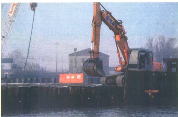
Pista di transito e palancoato strutturale
