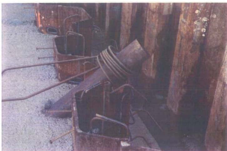
Predisposizione per la realizzazione dei tiranti
