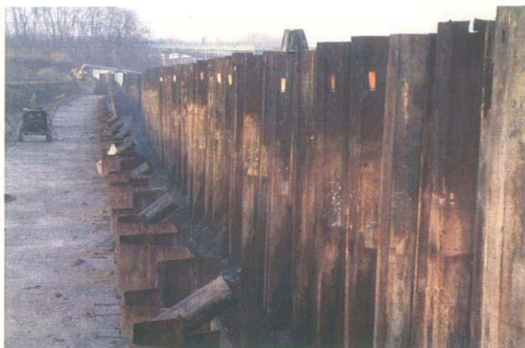
Tura provvisoria, palancoato strutturale e predisposizione tiranti
