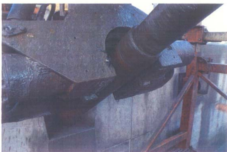
Fase di realizzazione dei tiranti sul cordolo di margine
