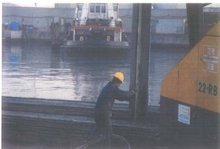
Fase di estrazione della palancola di tura provvisoria
