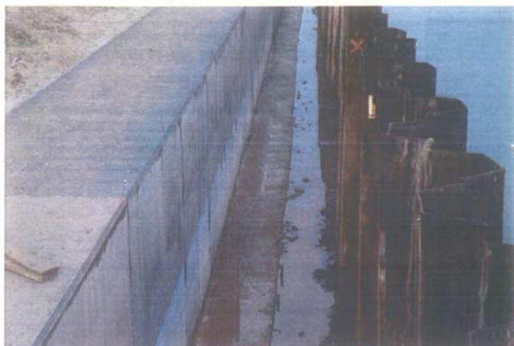
Tura provvisoria e margine completato
