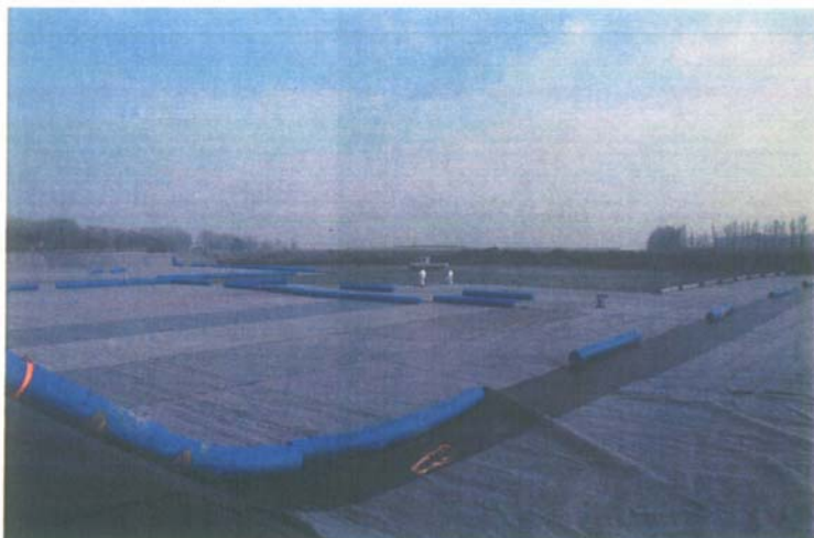
Impermeabilizzazione del bacino di accumulo n. 1 con telo HDPE e geotessuto
