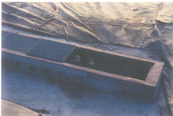
Rete di drenaggio dei geotubi nel bacino di accumulo n. 2
