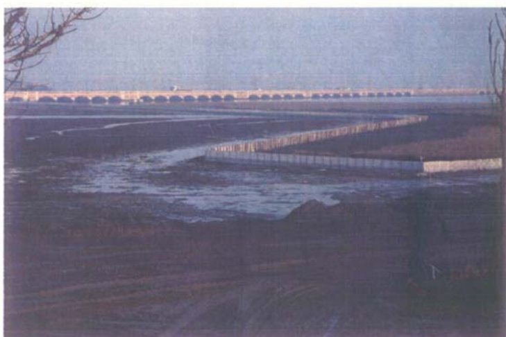
Rete idraulica antitorbidità all'interno della quale verranno dragati i materiali dalla fascia a ridosso delle sponde
