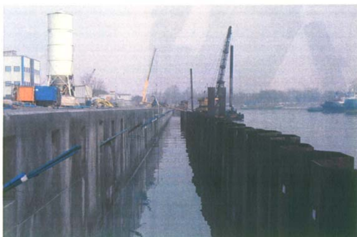
Marginamento con tiranti in fase di ultimazione e tura provvisoria
