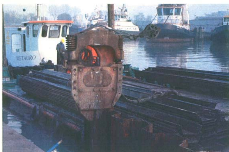
Estrazione della palancola di tura provvisoria
