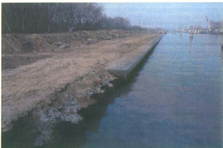
Palancoato strutturale e cordolo sommitale completato
